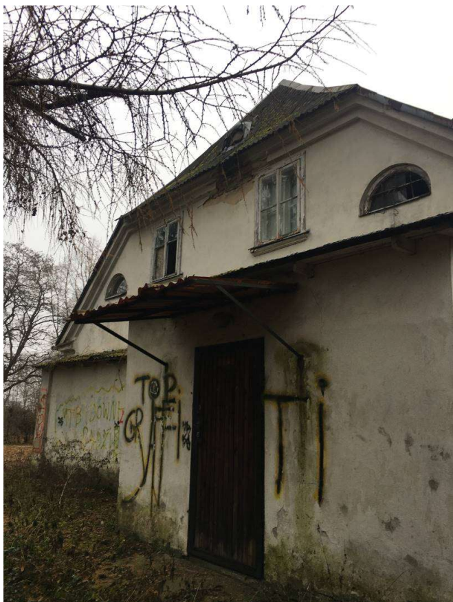
Fot. Prażmów, Dwór Ryxów, stan grudzień 2021, widoczne zawilgocenie elewacji, ubytki tynków, korozja biologiczna, degradacja spoin w odkrytym wątku ceglanym, dewastacja obróbek blacharskich, widoczna wtórna dobudówka od strony północnej,
