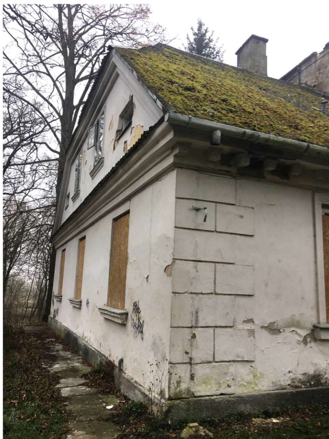
Fot. Prażmów, Dwór Ryxów, stan grudzień 2021, widoczne zawilgocenie elewacji, ubytki tynków, korozja biologiczna, dewastacja obróbek blacharskich
