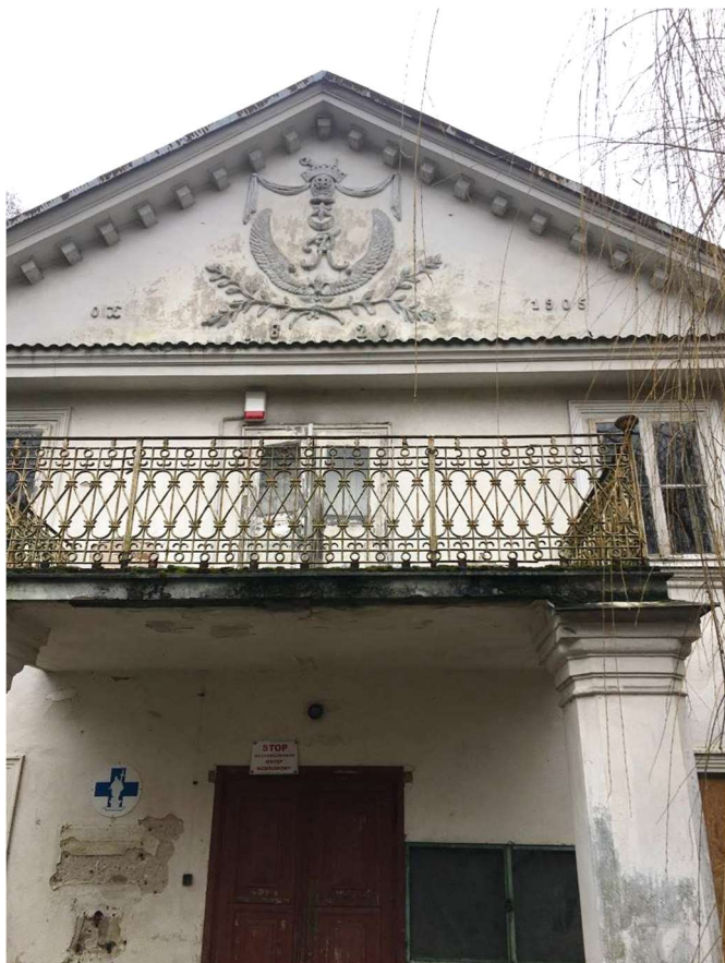
Fot. Prażmów, Dwór Ryxów, stan grudzień 2021, widoczne zawilgocenie elewacji, ubytki tynków, korozja biologiczna, dewastacja obróbek blacharskich, korozja konstrukcji stalowej balkonów.
