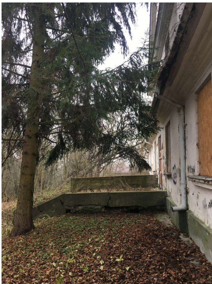
Fot. Prażmów, Dwór Ryxów, stan grudzień 2021, widoczne zawilgocenie elewacji ogrodowej, korozja biologiczna szczególnie intensywna w strefie zawilgoconego cokołu cementowego, niezgodny ze sztuką montaż rur spustowych.
