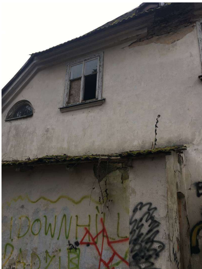
Fot. Prażmów, Dwór Ryxów, stan grudzień 2021, widoczne zawilgocenie elewacji, ubytki tynków, korozja biologiczna, wtórna dobudówka od strony północnej.
