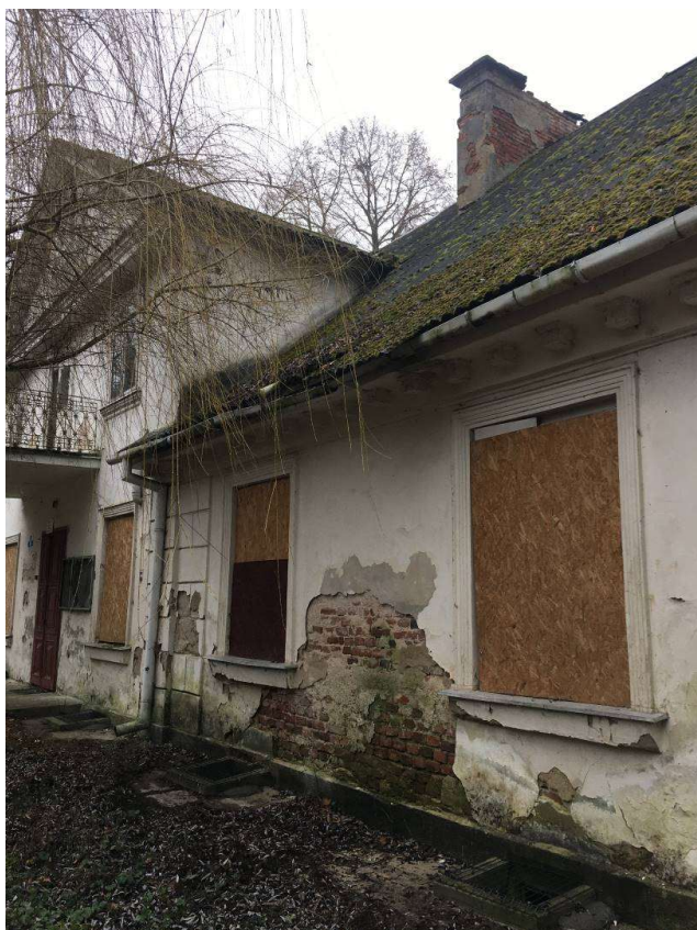
Fot. Prażmów, Dwór Ryxów, stan grudzień 2021, widoczne zawilgocenie elewacji, ubytki tynków, korozja biologiczna, degradacja spoin w odkrytym wątku ceglany, dewastacja obróbek blacharskich
