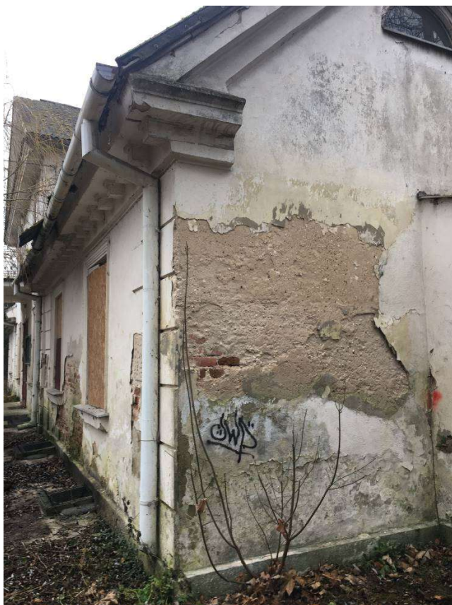
Fot. . Prażmów, Dwór Ryxów, stan grudzień 2021, widoczne zawilgocenie elewacji, ubytki tynków, korozja biologiczna
