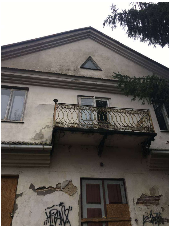
Fot. Prażmów, Dwór Ryxów, stan grudzień 2021, widoczne ubytki tynków, łuszczenie się wtórnych warstw farby, korozja biologiczna, degradacja spoin w odkrytym wątku ceglanym,
