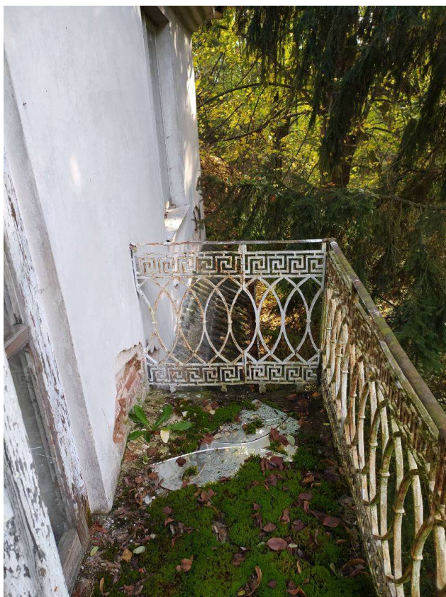
Fot. Prażmów, Dwór Ryxów, stan grudzień 2021, widoczne zawilgocenie elewacji, ubytki tynków, korozja biologiczna, korozja biologiczna płyty balkonowej
