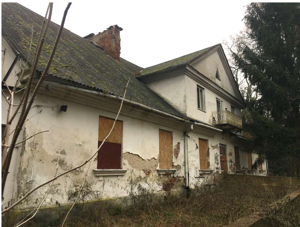
Fot. Prażmów, Dwór Ryxów, stan grudzień 2021, widoczne zawilgocenie elewacji, ubytki tynków, korozja biologiczna, degradacja spoin w odkrytym wątku ceglanym, dewastacja obróbek blacharskich.
